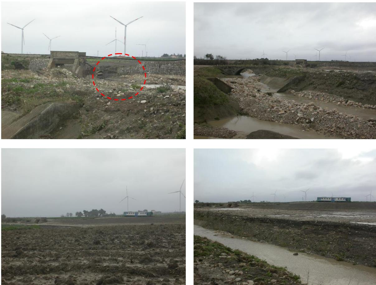
Figura 1.8 – Dettaglio dell' area n.1: vista dell'attraversamento ferroviario eroso che ha determinato il deragliamento del treno
