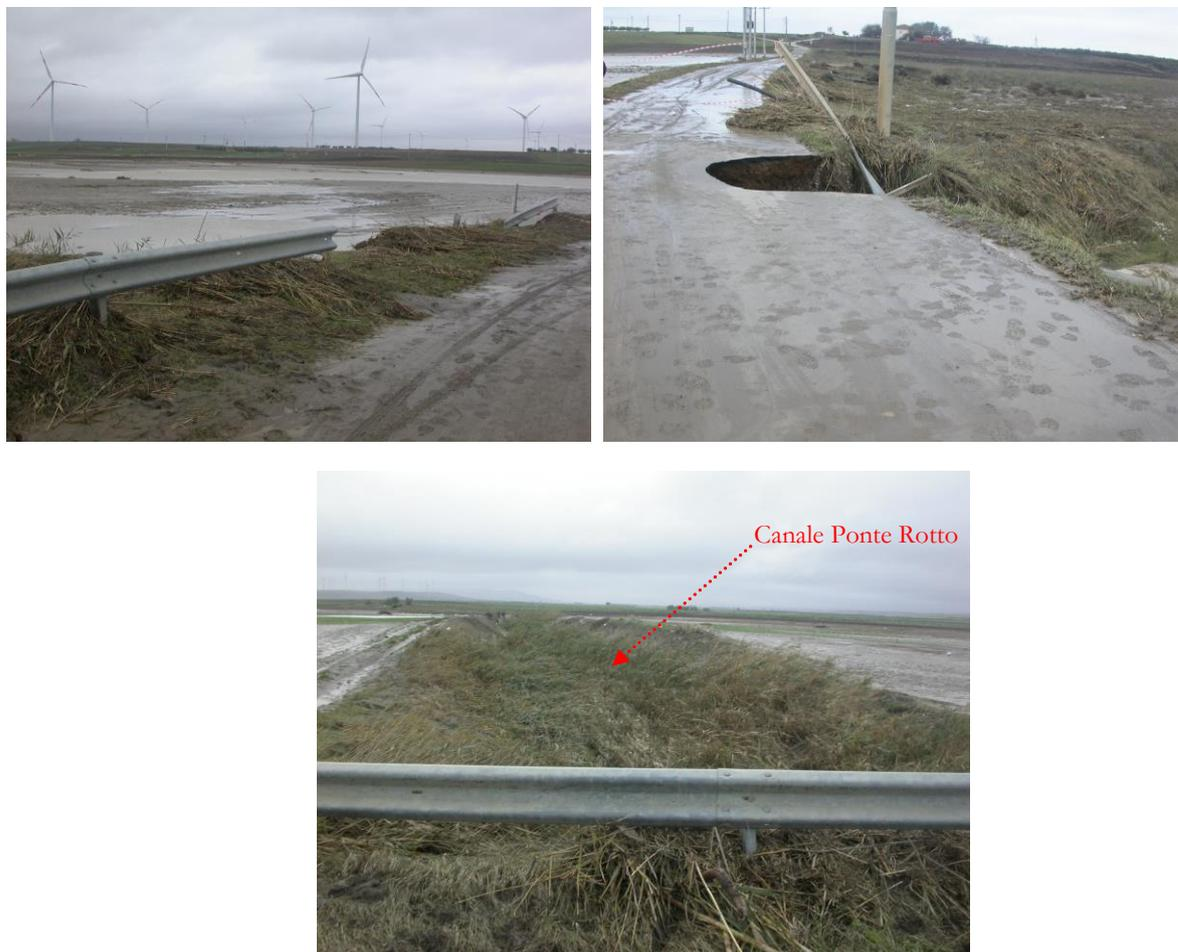
**Figura 1.9** – Dettaglio dell' area n.2: vista dell'attraversamento della strada comunale n. 16 eroso dal passaggio della piena; vista del canale Ponte Rotto a monte dell'attraversamento stradale.
