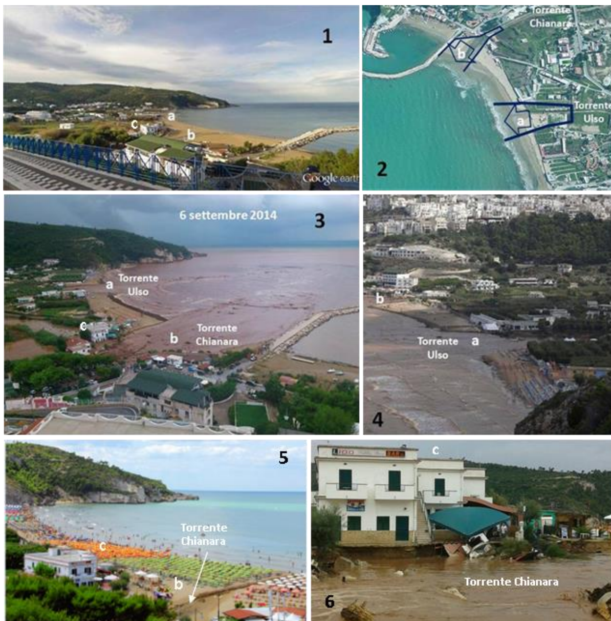
Figura 1.9 – Fascia costiera ad ovest dell'abitato di Peschici prima (Foto 1, 2 e 5) e dopo (Foto 3, 4 e 6) l'erosione dei torrenti Chianara ed Ulso (fonte: Note tecniche di F. Ortolani - www.meteogargano.org )
