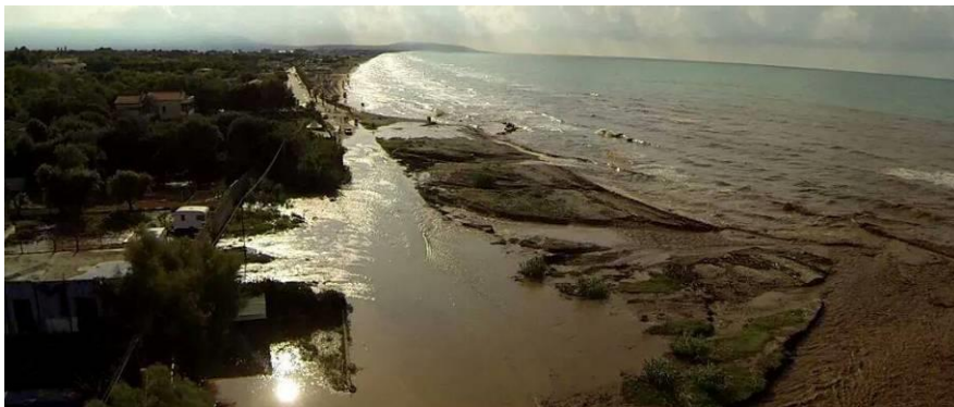
Effetti alluvione alla foce del torrente Romandato
