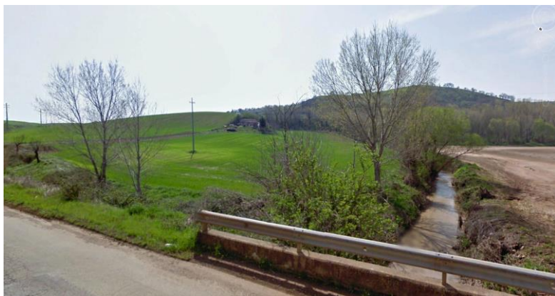
Aree a vegetazione arbustiva tratto OF02_m_DX in corrispondenza della sez. 30386.59 e della sez. 30350.48
