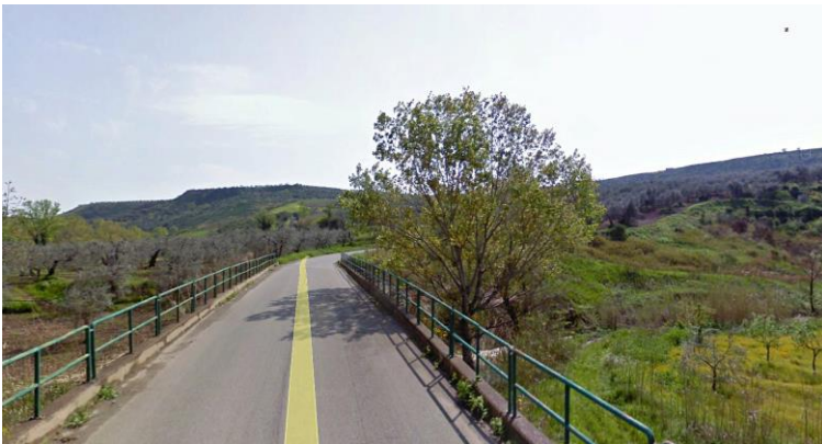
Uliveti tratto OF02_m_SX a valle della sez. 7103.085
