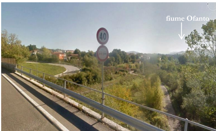
Tessuto urbano: tratto OF_01_C in corrispondenza della sez. 14205.72
