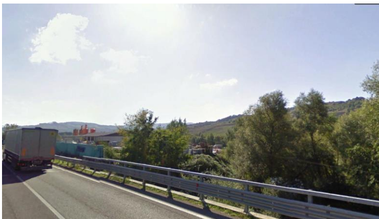
Insediamiento industriale tratto OF_01_C in corrispondenza della sez. 4816.84
