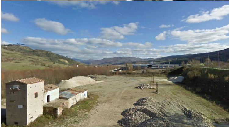
Insediamiento industriale tratto OF_01_F a valle della sez. 11337.6
