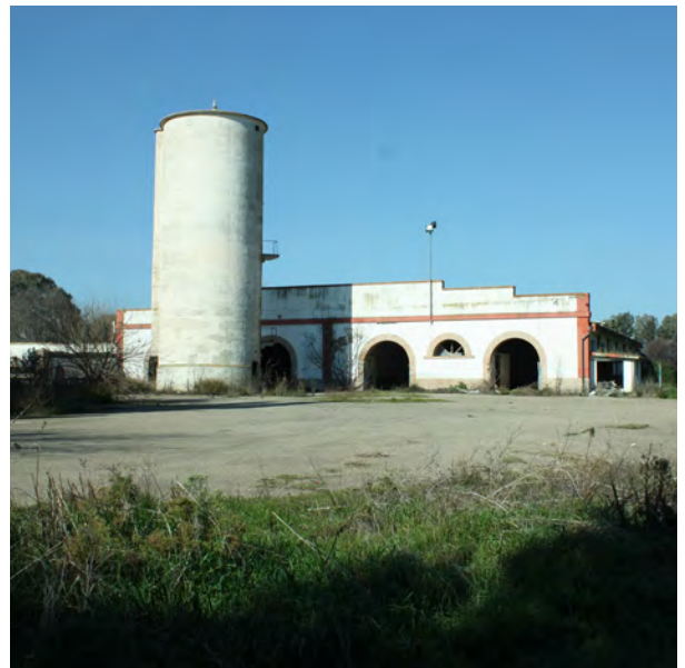
Uno degli edifici in stato di abbandono dell'ex Ovile Nazionale di Foggia.
